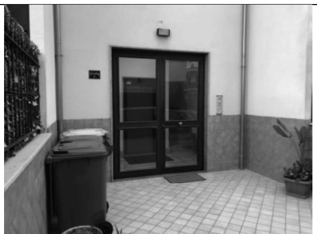
Ingresso al vano scala
