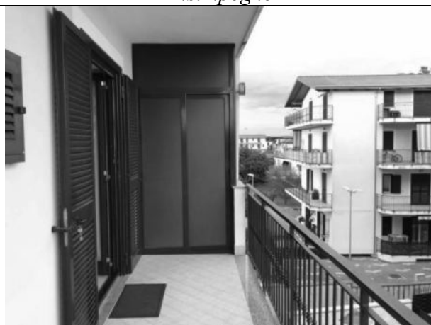
Balcone e ripostiglio esterno
